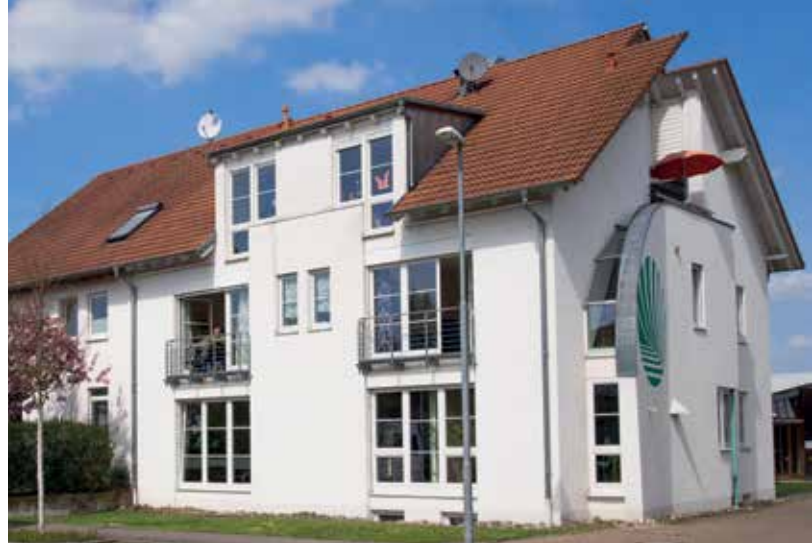
Abbildung 4: Gebäude in Freiburg mit zwei Probewohnungen im 1. Stock
